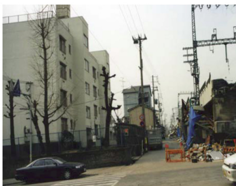
RC造・壁式構造の住棟（4階建て）
