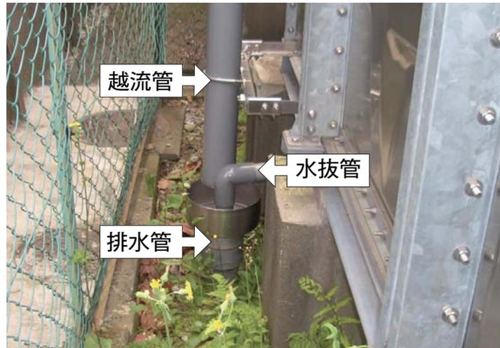
水抜管の先端が排水管の中に入っていて、排水口空間が確保されていません。
